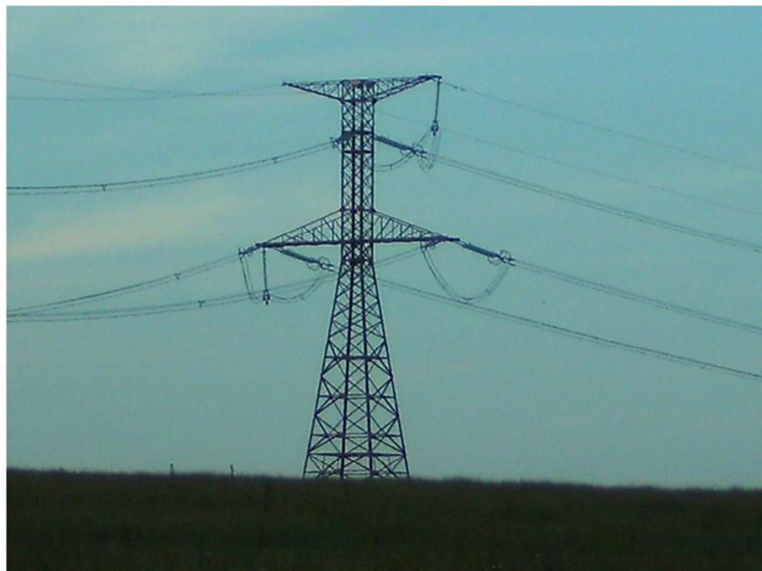
Abbildung 3-1: Beispiel für eine Einsystem Freileitung (380 kV)
