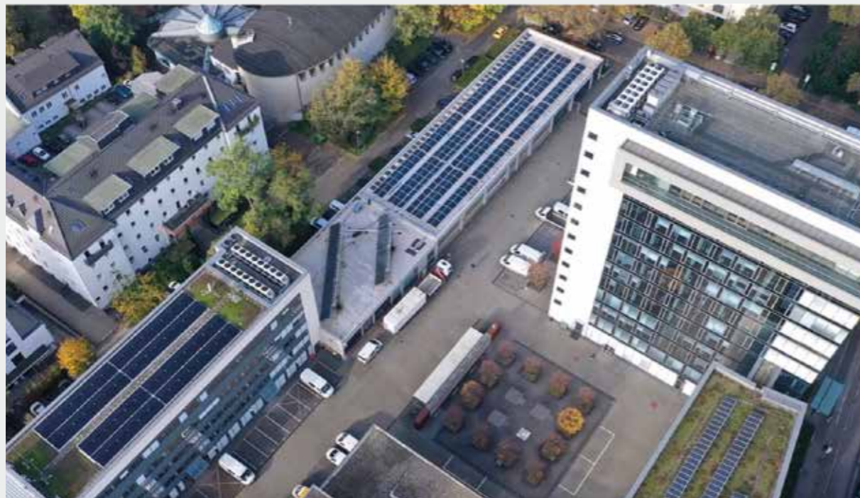
Neue und alte PV-Anlagen auf den Betriebsgebäuden am Standort „Rheinallee 41“
