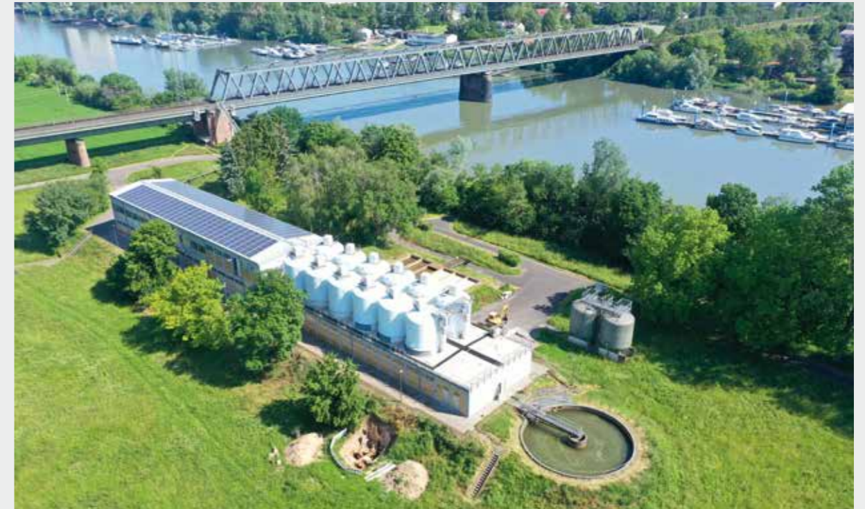
Wasserwerk auf der Petersaue
