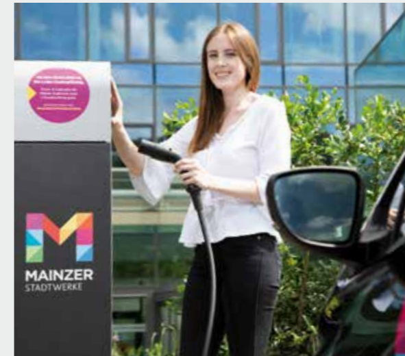
E-Ladesäule am Standort „Rheinallee 41“ Mainzer Stadtwerke
