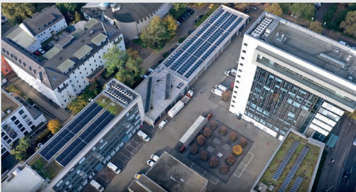
Neue und alte PV-Anlagen auf den Betriebsgebäuden am Standort „Rheinallee 41“
