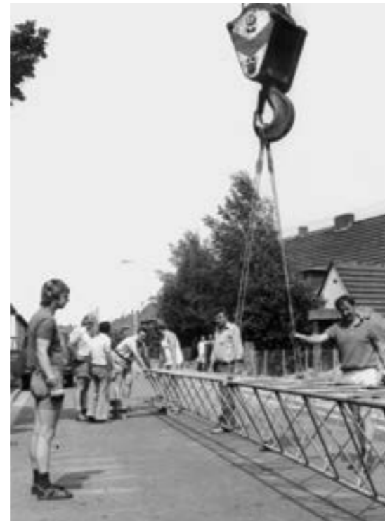
Aufstellen eines Funkmastes in den 1970er Jahren
