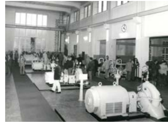
▲ Ein Blick ins Wasserwerk Hof Schönau 1978
