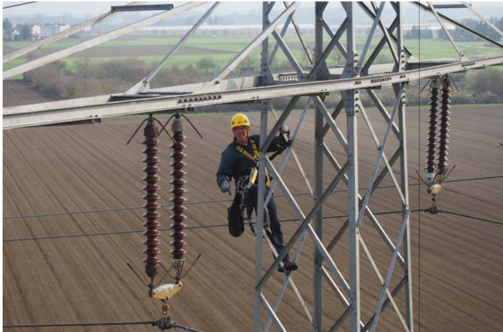
Ein KMW-Kollege auf einem Freileitungsmasten.
