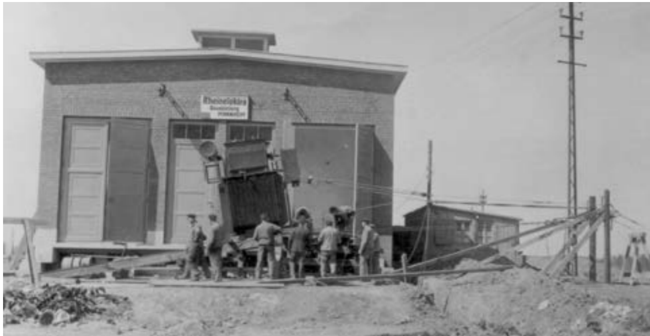
Umsetzen des Regeltrafos ins neue Schaltheus Hof Schönau
