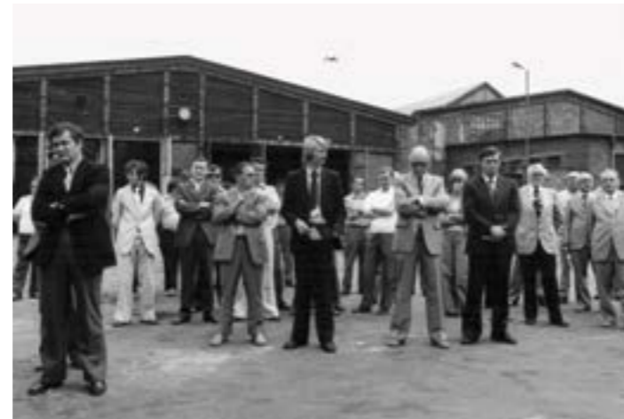
► Beschäftigte der Verkehrsbetriebe beim Spatenstich zum neuen Straßenbahnbetriebshof 1975
