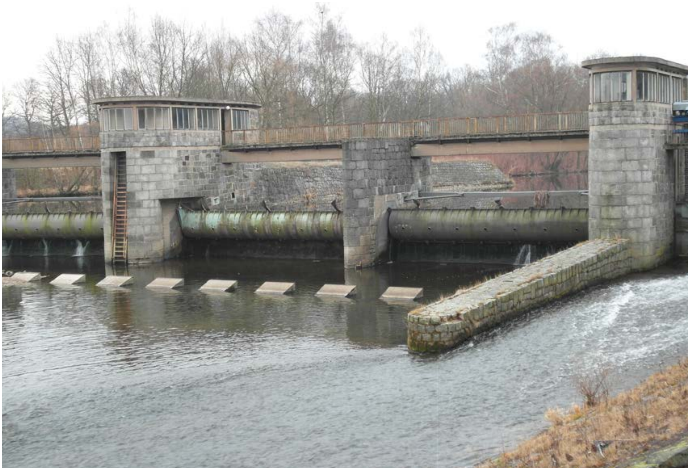
Wasserkraftanlage in Wiesenburg
