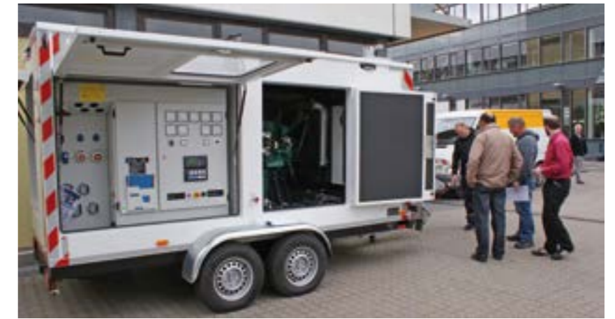
Ein Notstromaggregat mit einem Volvo-Motor, der eine Leistung von 202,4 kW oder 275 PS hat.
