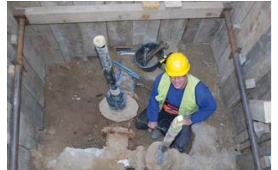
Ein Stadtwerke-Kollege in einer Baugrube zum Austausch eines Wasserschiebers.
