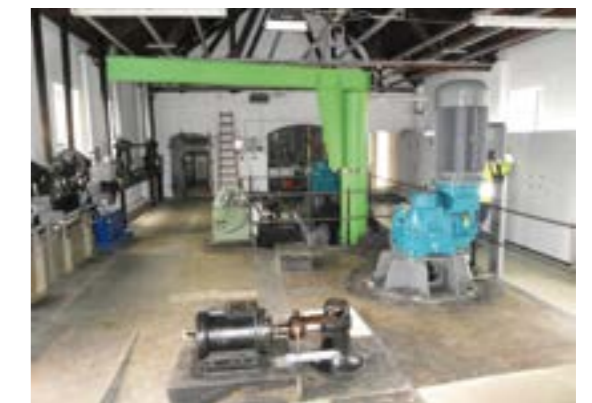
Turbinenhalle in Wiesenburg
