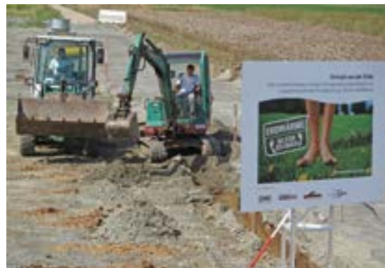
Als perfekter Ort für ein Tiefengeothermiekraftwerk im Oberrheingraben war Trebur ausgesucht worden.
