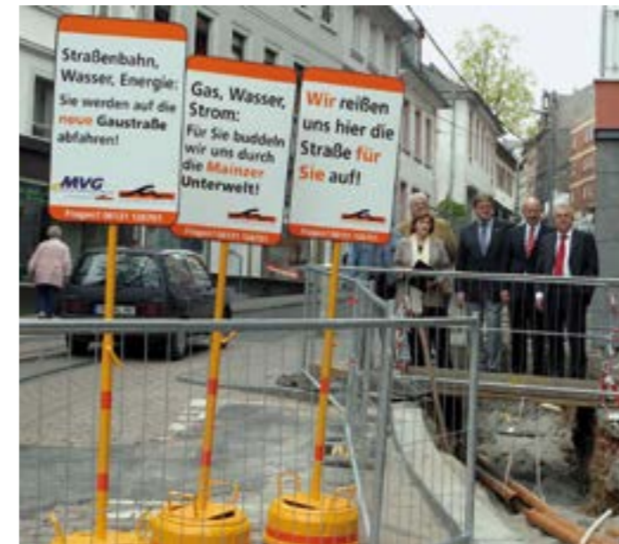
In der Gaustraße waren 2004 viele Abteilungen der Unternehmensgruppe mit Bauarbeiten beschäftigt. Allen voran die MVG.
