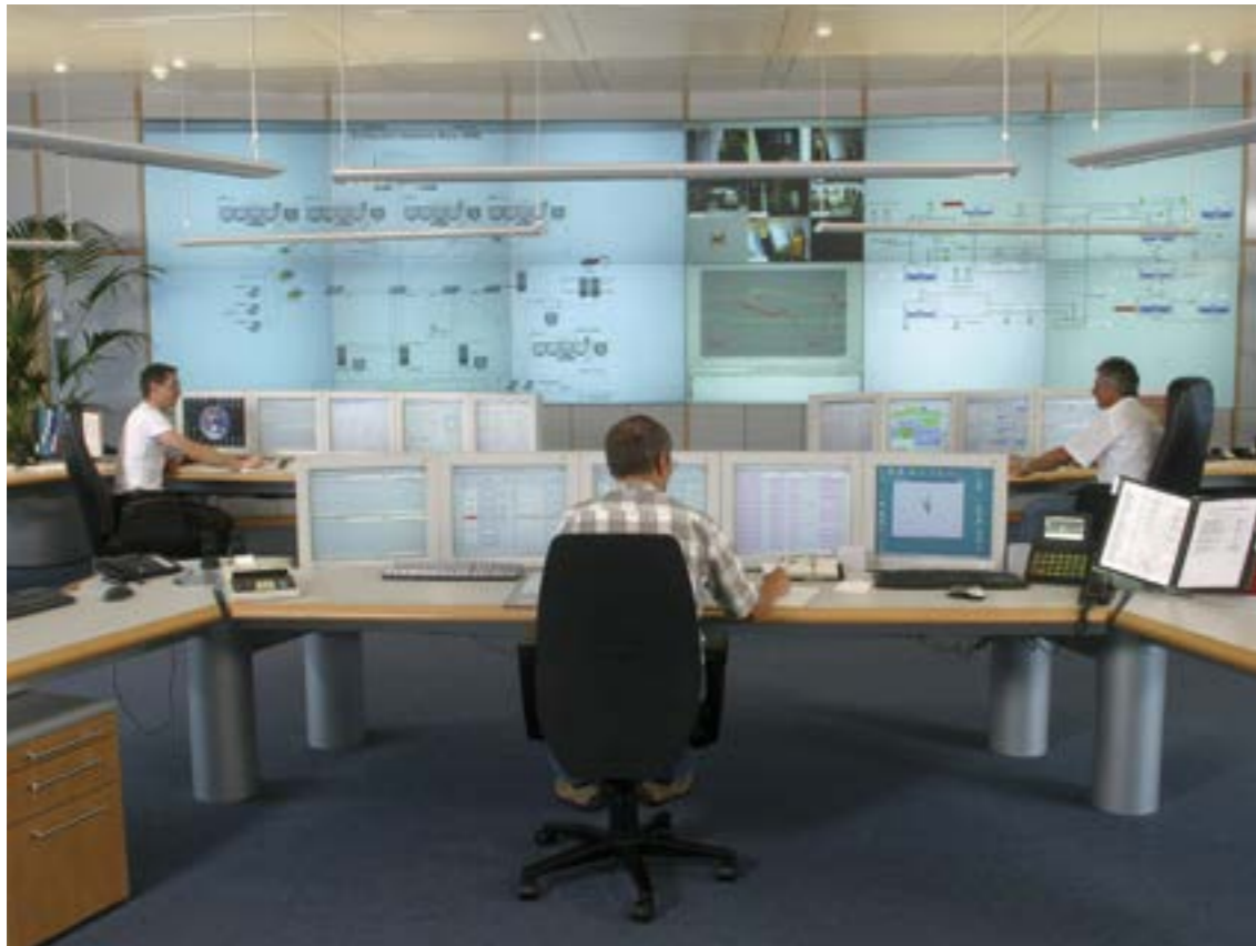
▲ Ab 1981 gab es eine Verbundwarte in der Raimundstraße 19–21. Diese wurde 2004 noch einmal auf den damals neuesten Stand der Technik gebracht.
