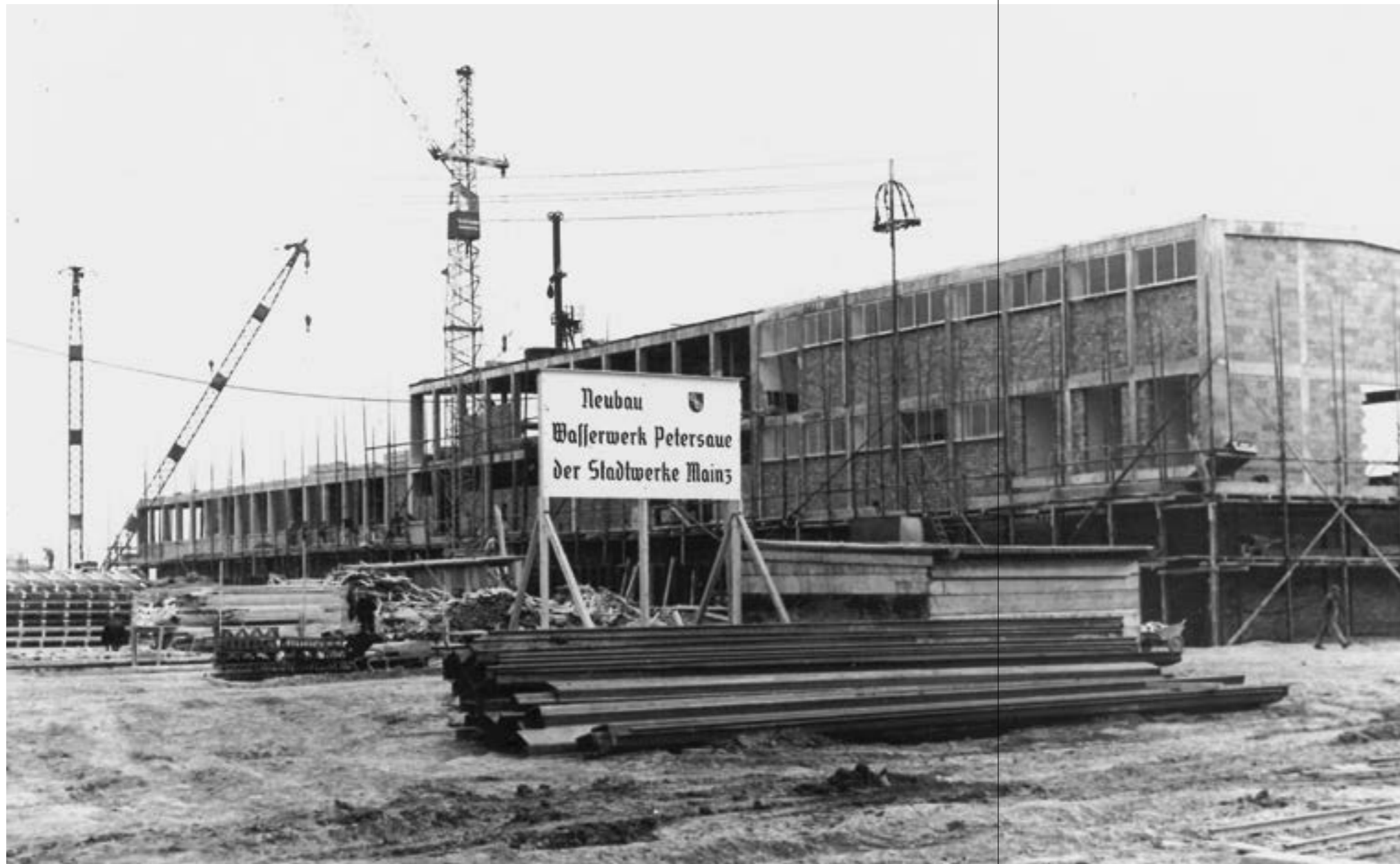
1957 waren die Arbeiten für das zweite große Mainzer Wasserwerk in vollem Gang.
