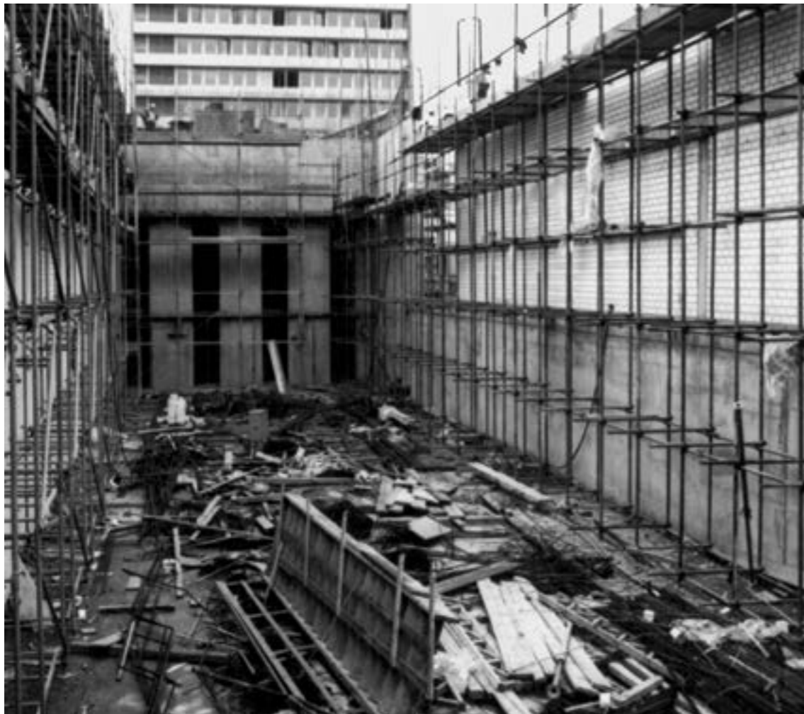
▼ Ein Drittel der Regalfläche des Lagers befindet sich unter der Erde.
