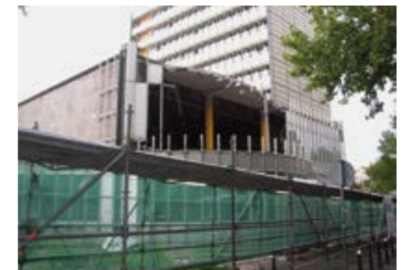
Zehn Jahre nach Fertigstellung von Lager und Betriebsgebäude wurde die Fassade des Hochhauses saniert. Auch Kantine sowie Kundencenter erhielten einen neuen „Look“. Zwischenzeitlich wurde in Containern gearbeitet.
