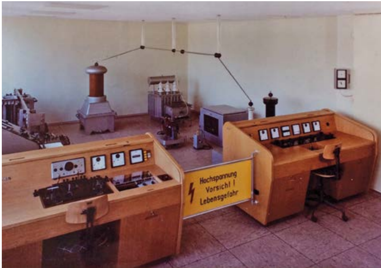
▲ Prüfanlage für Wandler
