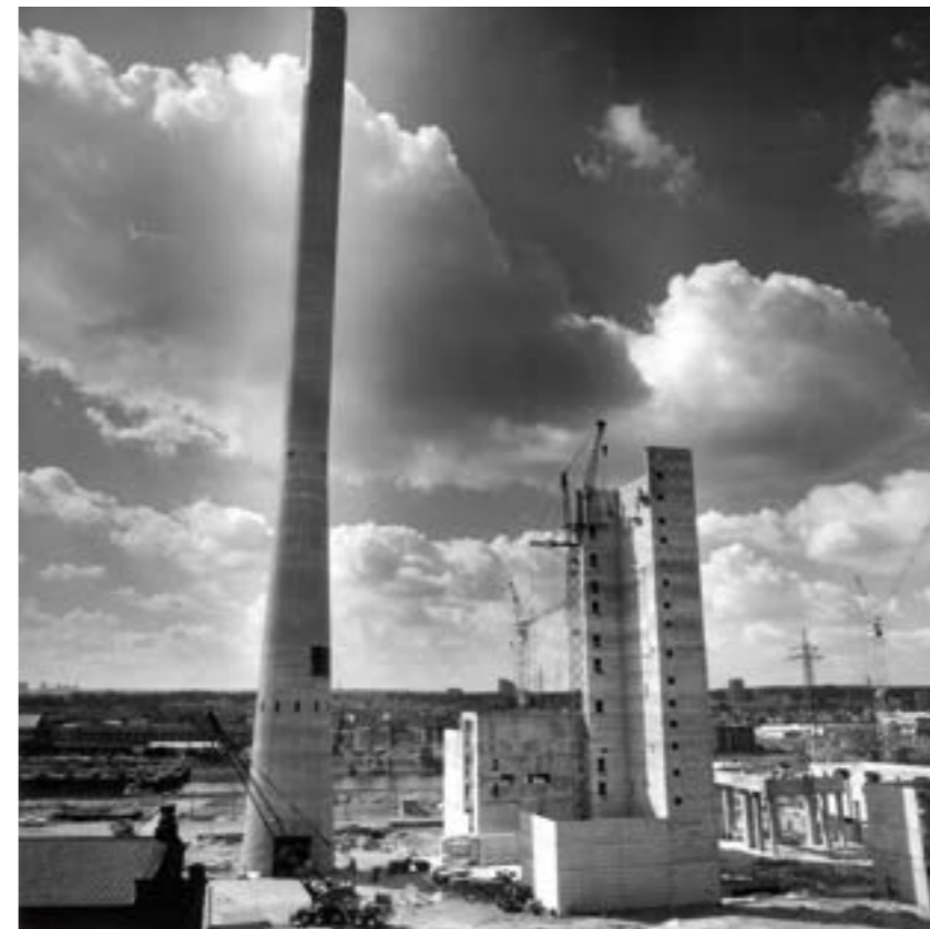
◀ Eine Aufnahme von 1974: Luftfilteranlagen, Rauchgaskanalgebäude und Kesselhaus befinden sich noch im Bau.
