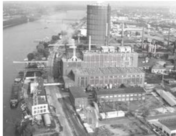
Der Gasspeicher prägte das Panorama der Rheinfrost knapp 20 Jahre lang. 1974 wurde er demontiert. Ein Erhalt als Industriedenkmal wäre zu kostspielig gewesen.
