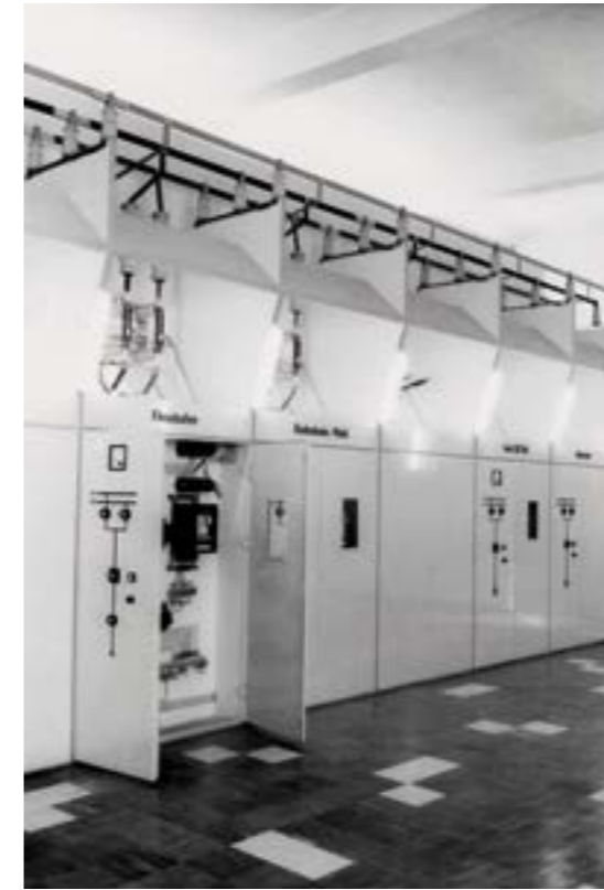
◀ Ein Blick in das frühere Umspannwerk am Floßhafen. Heute ist dort eine Lagerstätte der Stadtwerke.
