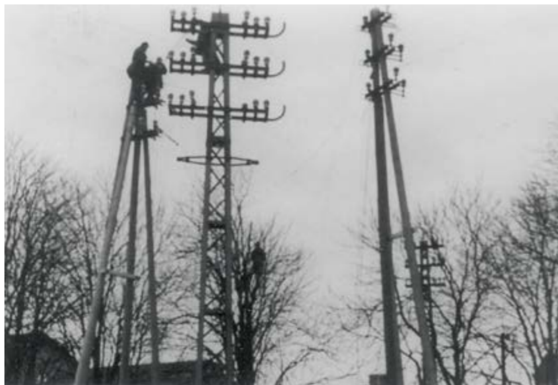
1938: An der Straße zwischen Hof Schönau und Rüsselsheim kommt es zur Umarmierung von Freileitungs-Gittermasten von 20 Kilovolt auf Freileitung.
